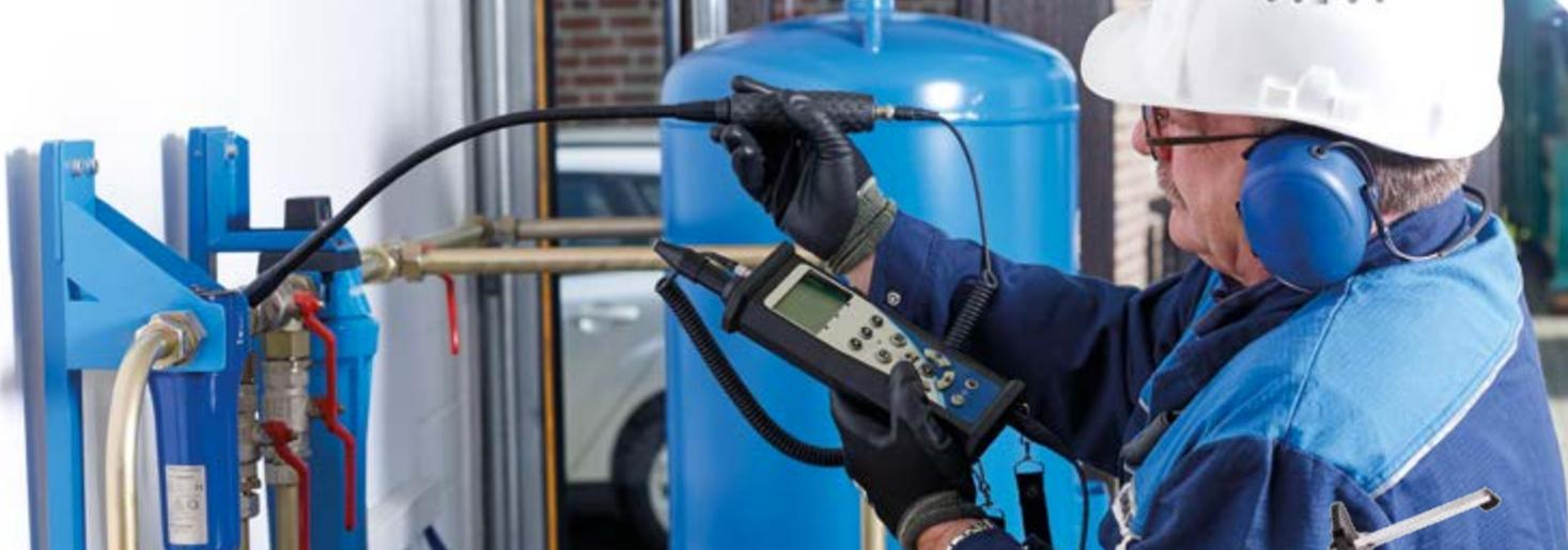
Umfassender Service zu transparenten Preisen: Mit modernster Ultraschalltechnik spüren wir sämtliche Leckagen auf, übernehmen die Kennzeichnung in den Hallenplänen sowie an den Anlagen und kümmern uns um die Abdichtung.
